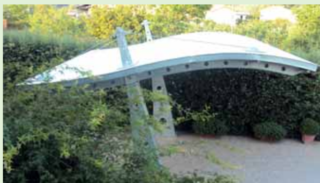
La copertura per posti auto all'aperto realizzata da Officine Talarico
